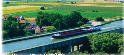
マイン=ドナウ運河 マイン川のバンベルクからドナウ川のケールハイムまで全長約171kmに及ぶ運河。16の水門を通過し水位を調整しながら船は進みます。1992年に完成した運河で、これにより北海から黒海まで水路で繋がることになりました。
