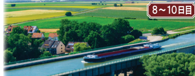
マイン＝ドナウ運河 マイン川のバンベルクからドナウ川のケルハイムまで全長約171kmに及ぶ運河。16の水門を通して水位を調整しながら船は進みます。1992年に完成した運河で、これにより北海から黒海まで水路で繋がることになりました。
